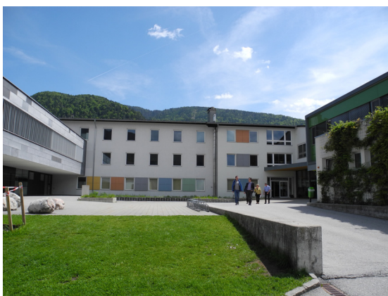
Innenhof mit Volksschule und NMS rechts
